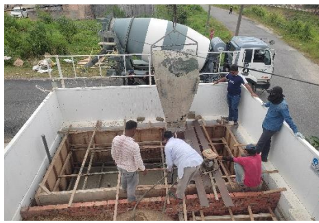
PEMBINAAN STRUKTUR KOLAM
