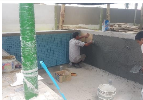
KERJA-KERJA KEMASAN KOLAM
