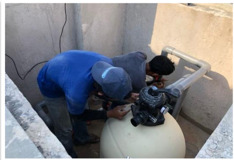
KERJA-KERJA MEKANIKAL & ELEKTRIKAL
