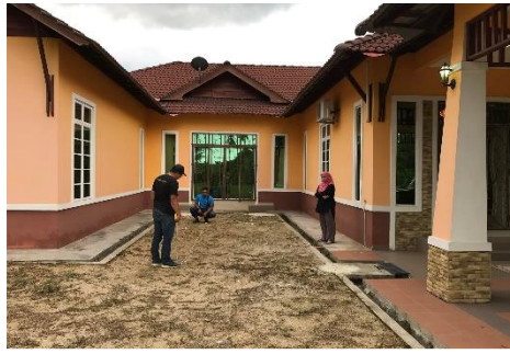
LAWATAN TAPAK & KERJA-KERJA MENGUKUR
